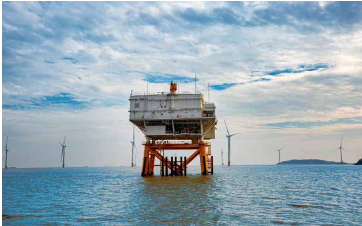
国电电力的舟山海上风电项目
